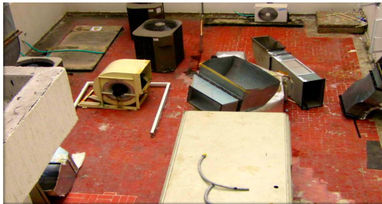
Figura 18. Foto residuos de partes de aires acondicionado en patios del Hospital Universitario del Caribe
