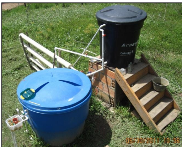
Figura 22. Tanque de regulación y sedimentador
