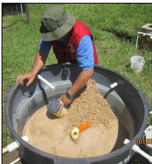
Figura 46. Raspado capa de arena superior
