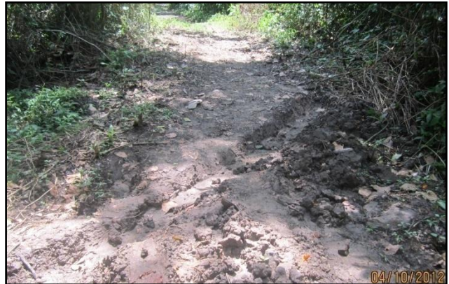
Figura 51. Zanjas de desvío de agua
