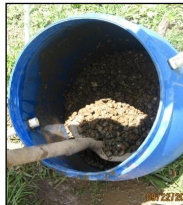
Figura 6. Retiro manual del lecho
