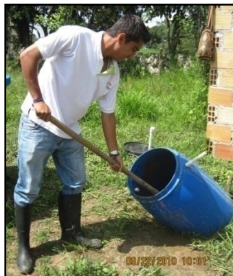
Figura 5. Lavado lecho filtrante
