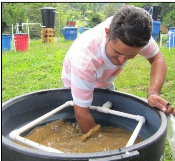
Figura 45. Lavado Filtro Grueso Descendente
