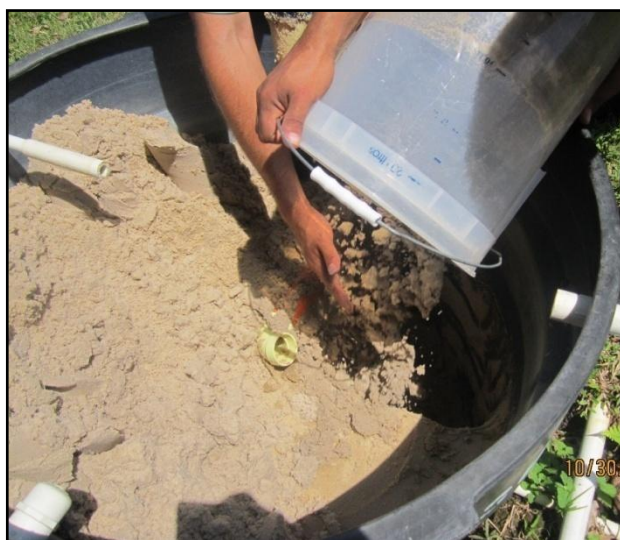
Figura 47. Colocación de arena lavada (re-arenado)
