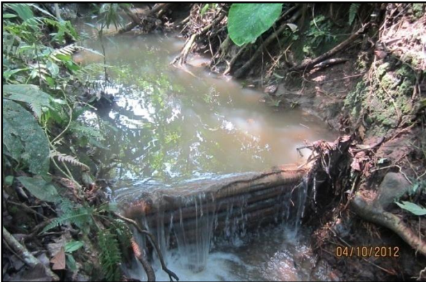
Figura 50. Trincho en la quebrada La Nacuma
